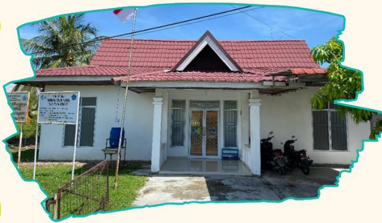
Gambar 2.4 Kantor Wilayah Kerja Sungai Pakning
